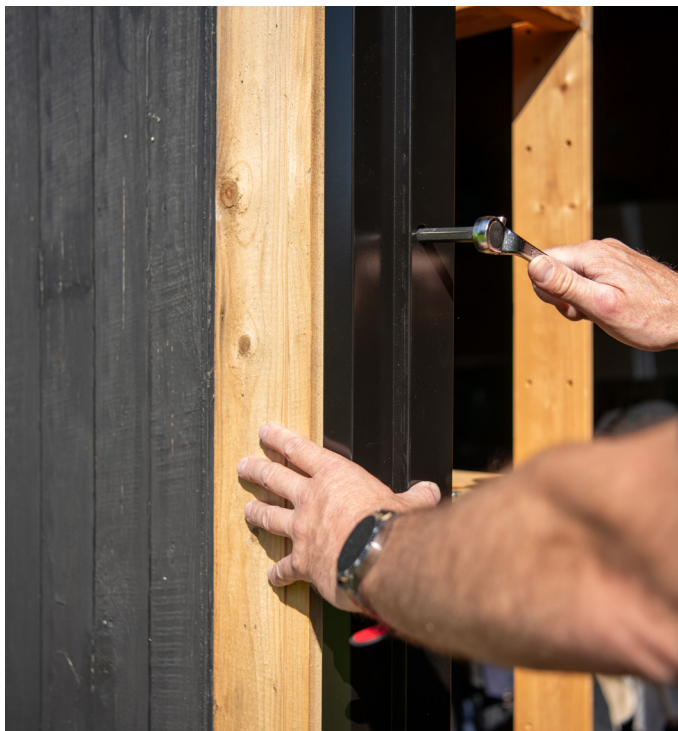
Steg 3. Monter karmen. Plasser karmen i døråpningen, og mål toppstykket, slik at karmen er i vater. Lodde deretter karmsidene, slik at karmen står støtt mot underlaget. Terskelen må ligge helt stødig.
