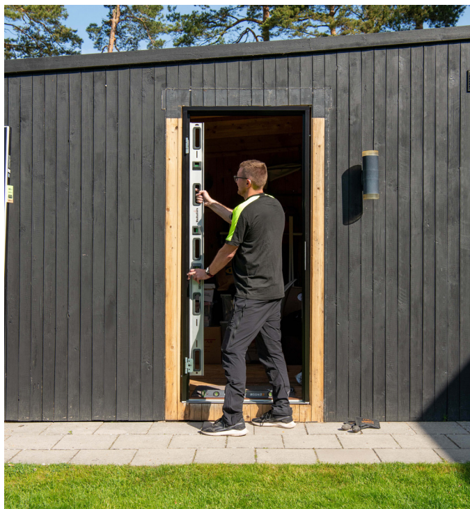
Steg 4. Fest hengselsiden. Skru hengselsiden fast i vegg. Start øverst, og sjekk at karmen er i lodd. Dersom karmsiden har vridd seg, juster før skruene strammes.
