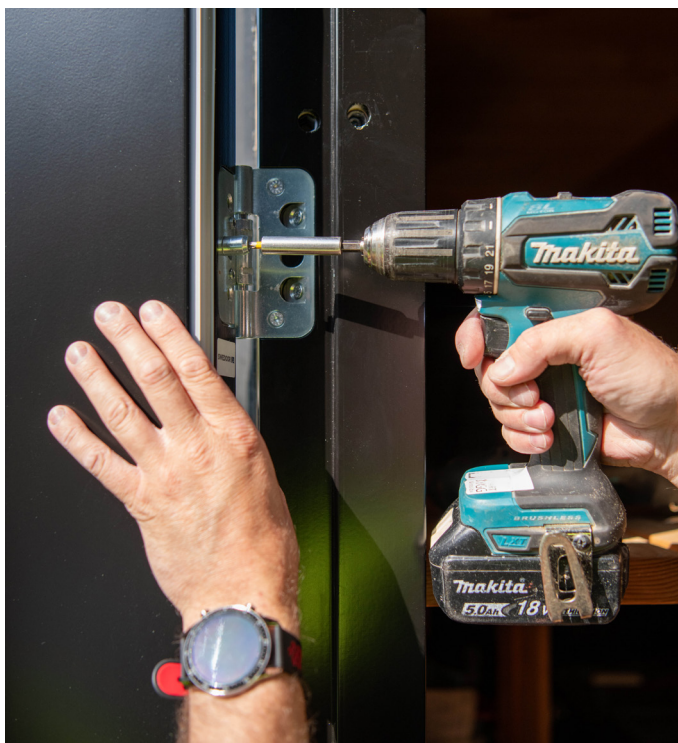
Steg 5. Monter og juster døren. Når hengselsiden er på plass, er det på tide å hekte på selve døren. Denne har en bakkantsikring som døren henges på, før den deretter hektes på hengslene. Skru de medfølgende skruene gjennom hengslene, og inn i døren.
