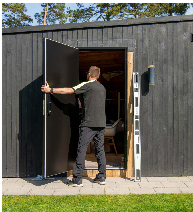
Steg 6. Siste steg. Glippet mellom karm og vegg skjules med utforing og eventuelt fuge. Ved montering av terskel skal sporet fylles med silikon, før beslaget trykkes på plass. Det er viktig at både terskelen og terskelbeslaget sitter helt rett.
