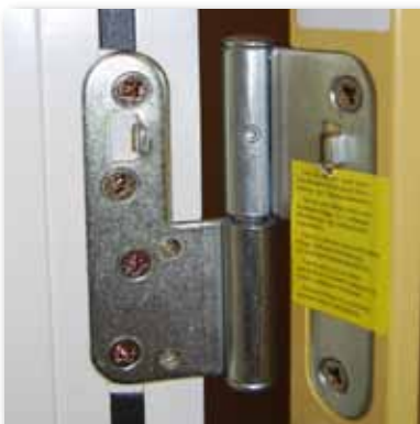
Hengsler med mulighet for justering i høyden.
